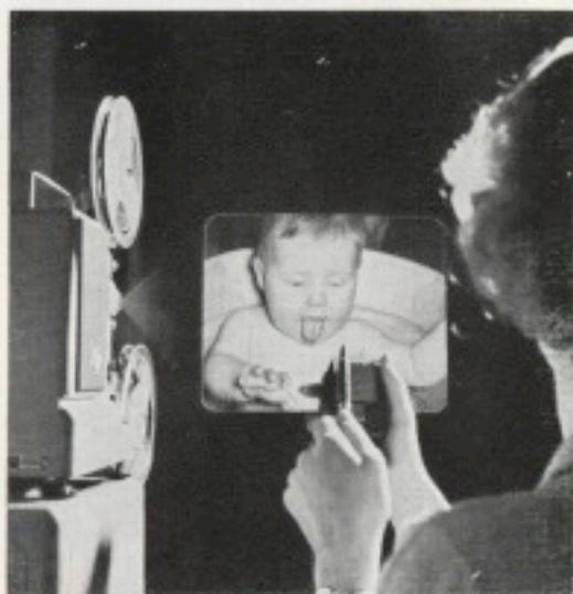
Abb. 19 Kennzeichnung des Tonbandes bei synchroner Bildvorführung durch Besprechen und Klopfzeichen auf das Mikrofon
